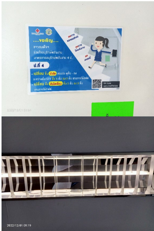
ใช้หลอดไฟประหยัดพลังงานและโคมไฟสะท้อนแสง
