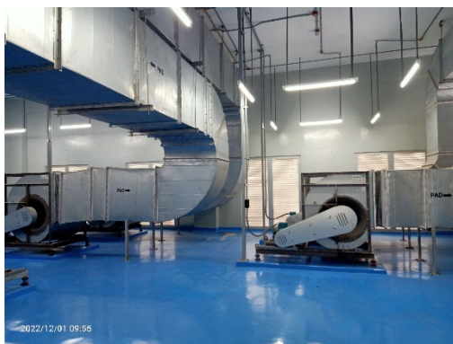
ภาพที่ 2-9 ระบบระบายอากาศและอัดอากาศ อาคารศูนย์รักษาพยาบาล
